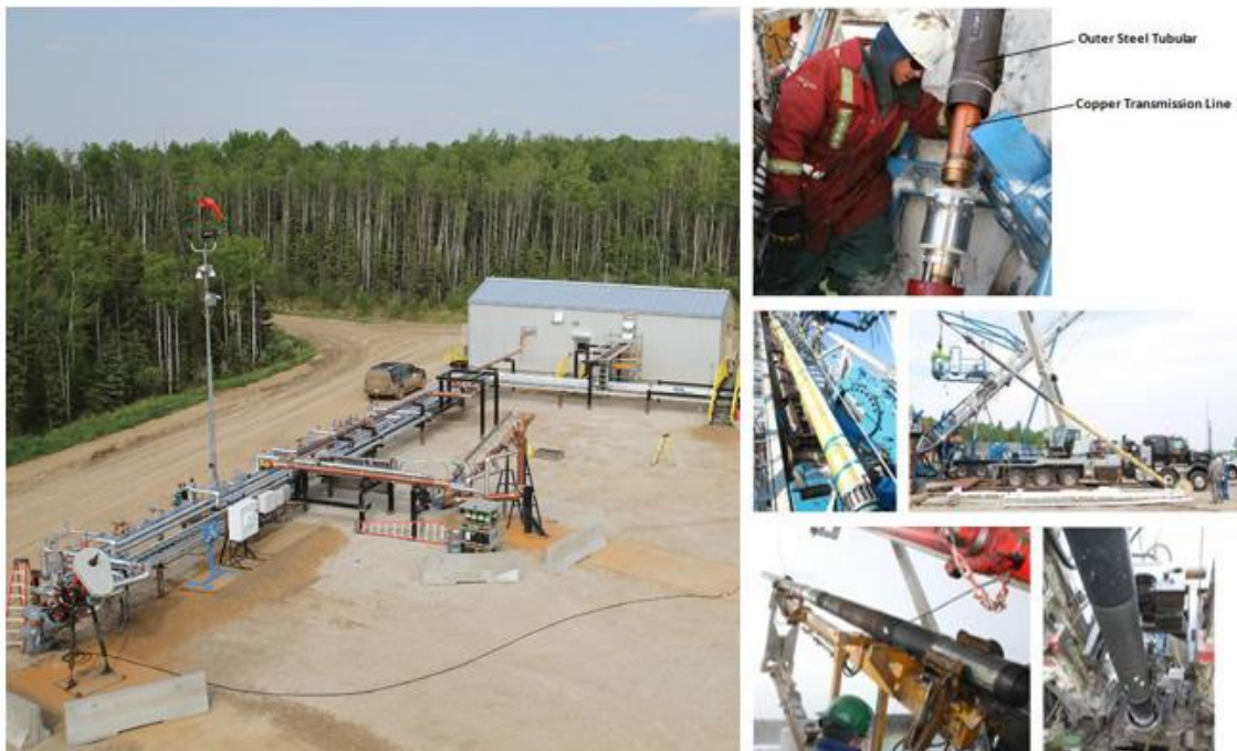
Figura 4 - Instalação de projeto de aquecimento EM em campo
