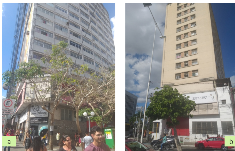
Figuras 4.15: Edifícios mistos presentes na rua Marquês do Herval
