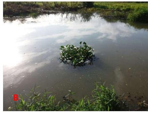
**Figura 4.** Instalação das macrófitas na lagoa que recebe o esgoto dos presídios em Mangabeira(A); bem como no ponto P4 (B).
