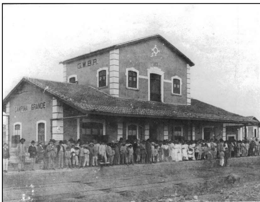
Figura 6 – Estação Ferroviária de Campina Grande -1907
