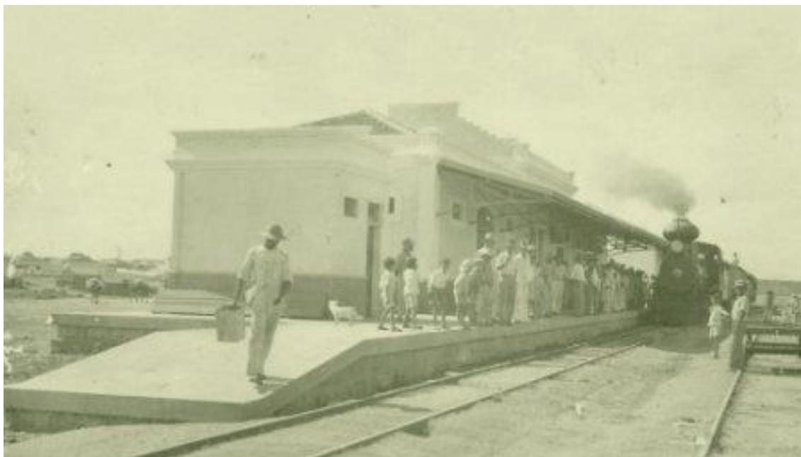
Figura 11 – Estação Ferroviária de Caraúbas
