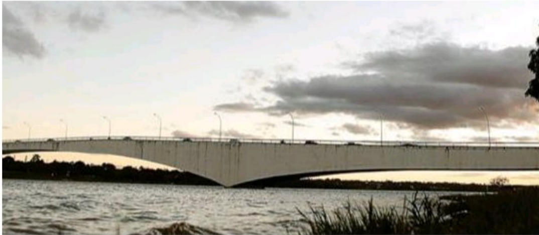
Figura 6.1 – Arco abatido não prismático com variação da altura não simétrica
