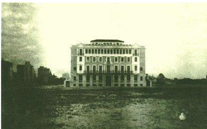
Figura 7 – Fachada da Faculdade de Direito do Rio de Janeiro
