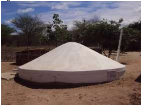
Figura 10- Cisterna de Placa– Olivedos-PB
