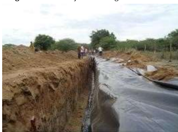
Figura 11- Construção da Barragem subterrânea
