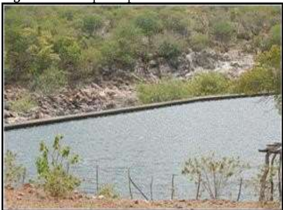
Figura 12 - Tanque de pedra Umarizal-RN.
