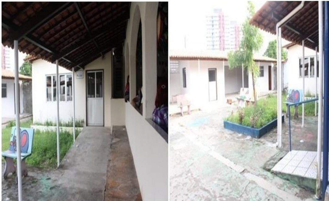
Figura11: Instalações em construção da VVJF
