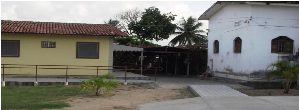
Figuras 7: Corredor de entrada principal e rampa de acesso no ano de 2009
