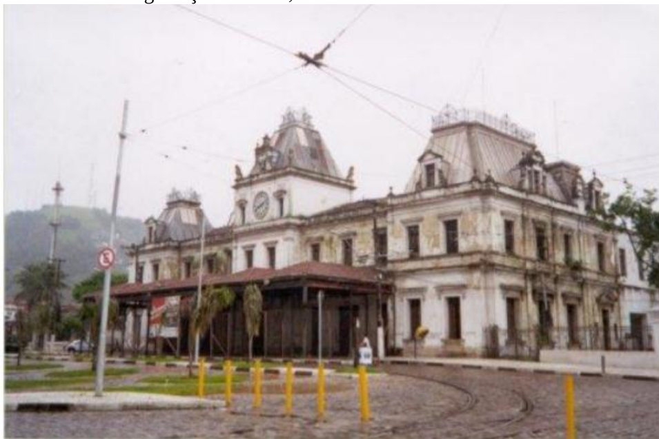
Figura 12 - Imagem do ano de 2004 da Antiga Estação de Trem do Valongo em estado de degradação material, antes do tombamento de 2010
