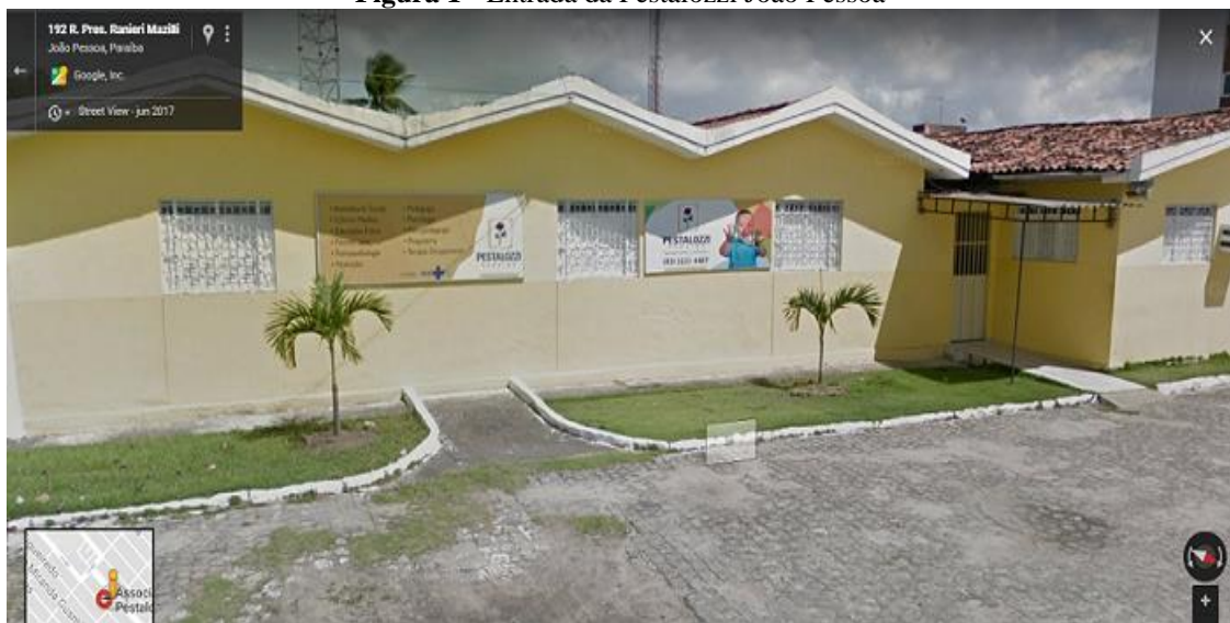
Figura 1 - Entrada da Pestalozzi João Pessoa
