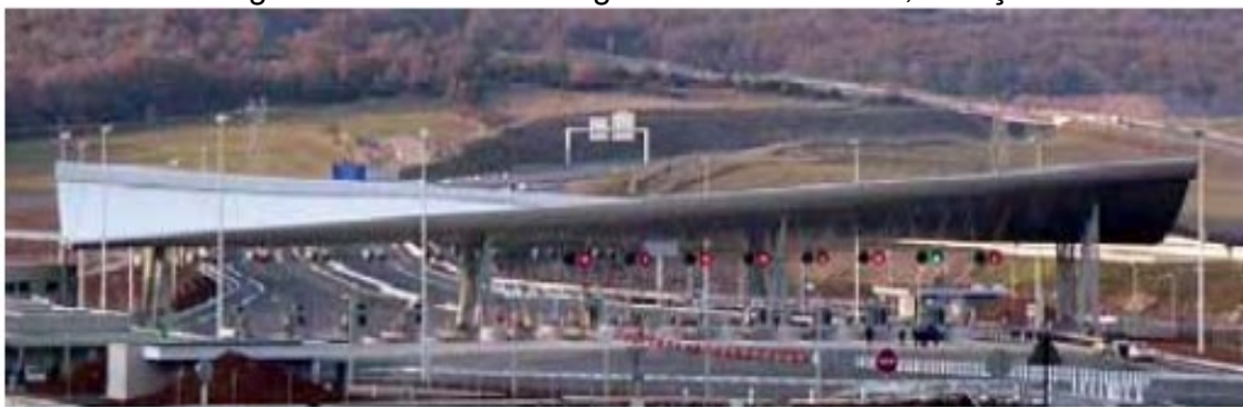
Figura 4 - Posto de Pedágio do Viaduto Millau, França.
