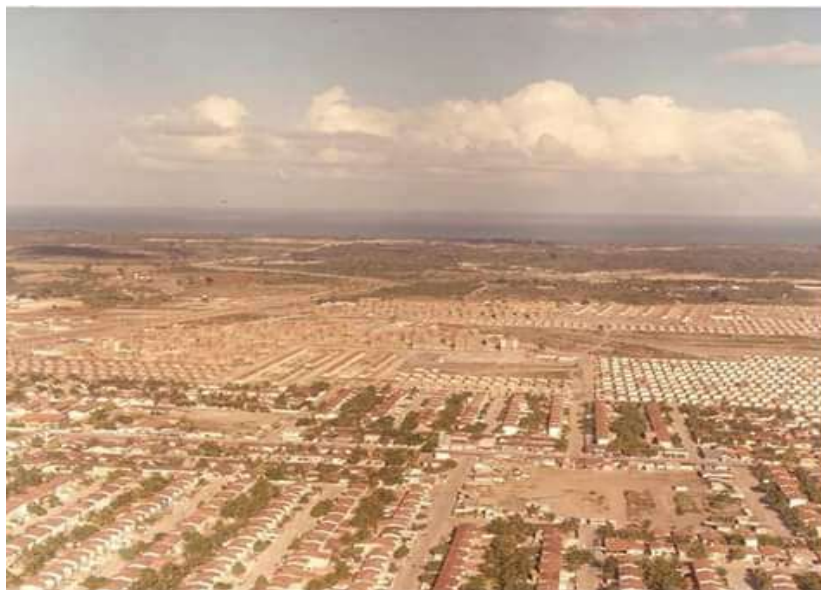
Figura 03: Bairro em construção. Foto cedida pela CEHAP
