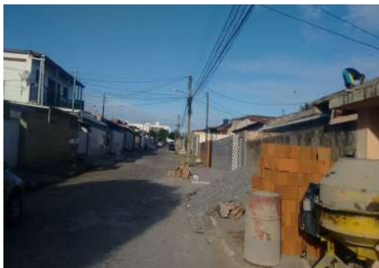
Figura 18: Rua Engenheiro Luiz Ribeiro Beltrão, construção de novos prédios. FOTO: Tatiane Matos, 2016
