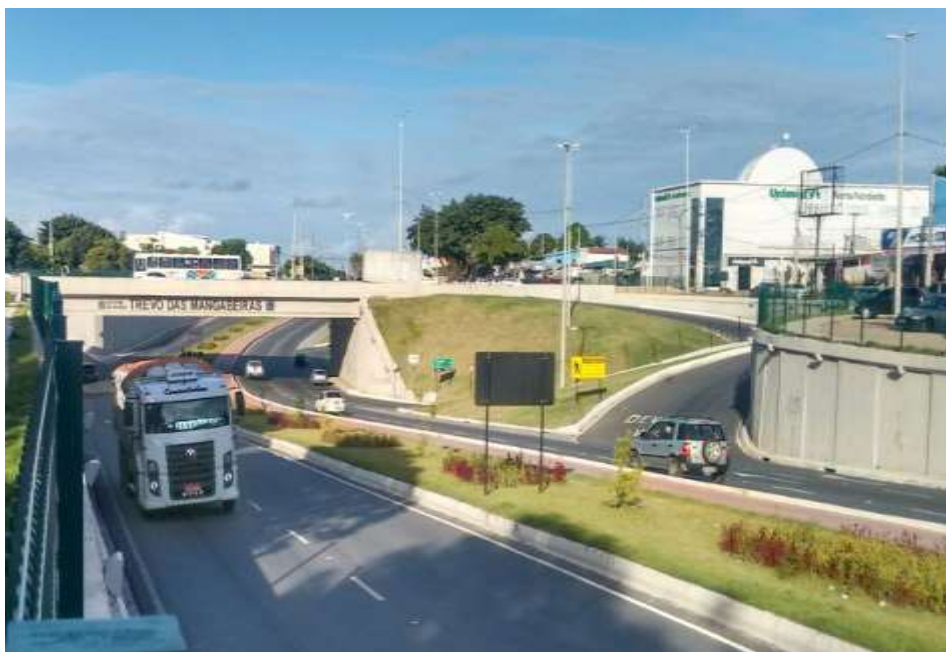
Figura 04: Trevo das Mangabeiras, entrada principal do bairro, inaugurado em 31 de agosto de 2015. FOTO: Tatiane Matos, 2016.
