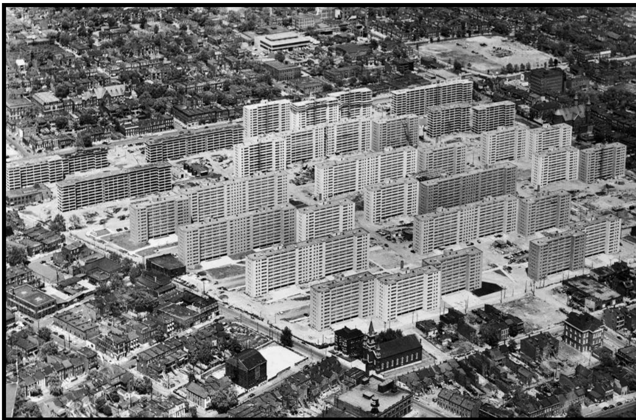
Conjunto de prédios que formava o Pruitt-Igoe . Fonte da imagem: https://www.theguardian.com/cities/2015/apr/22/pruitt-igoe-high-rise-urban-america-history-cities Acessado em 18 de março de 2019
