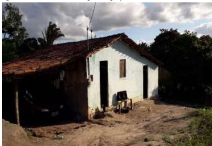
Figura 14: Casa de um dos moradores construída com apoio da comunidade e participação da ADESCO
