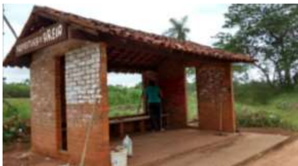
Figura 15: Mutirão de reforma da parada de ônibus na comunidade Chã de Jardim
