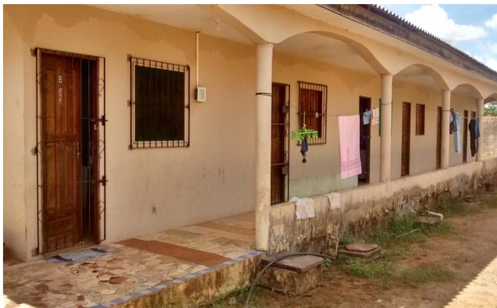
Figura 30: Vila de quitinetes e sua extensão de cinco quartos (o último cômodo foi reservado para ser um depósito). Estes estabelecimentos para residência temporária são comuns em Oiapoque
