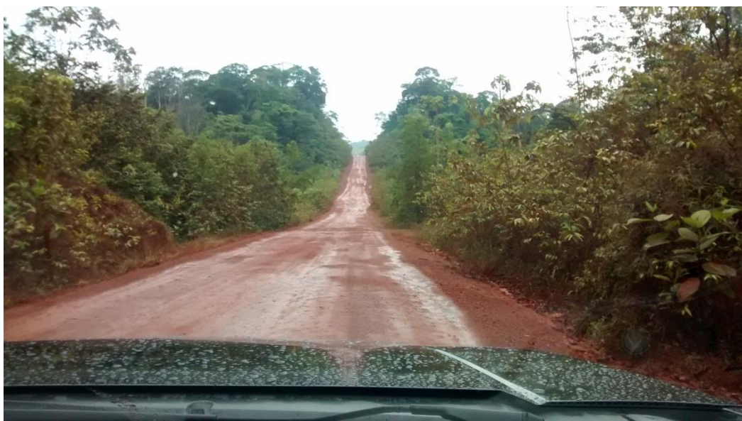
Figura 12: Trecho sem asfalto da BR-156 (sentido Oiapoque/Macapá em janeiro de 2020)
