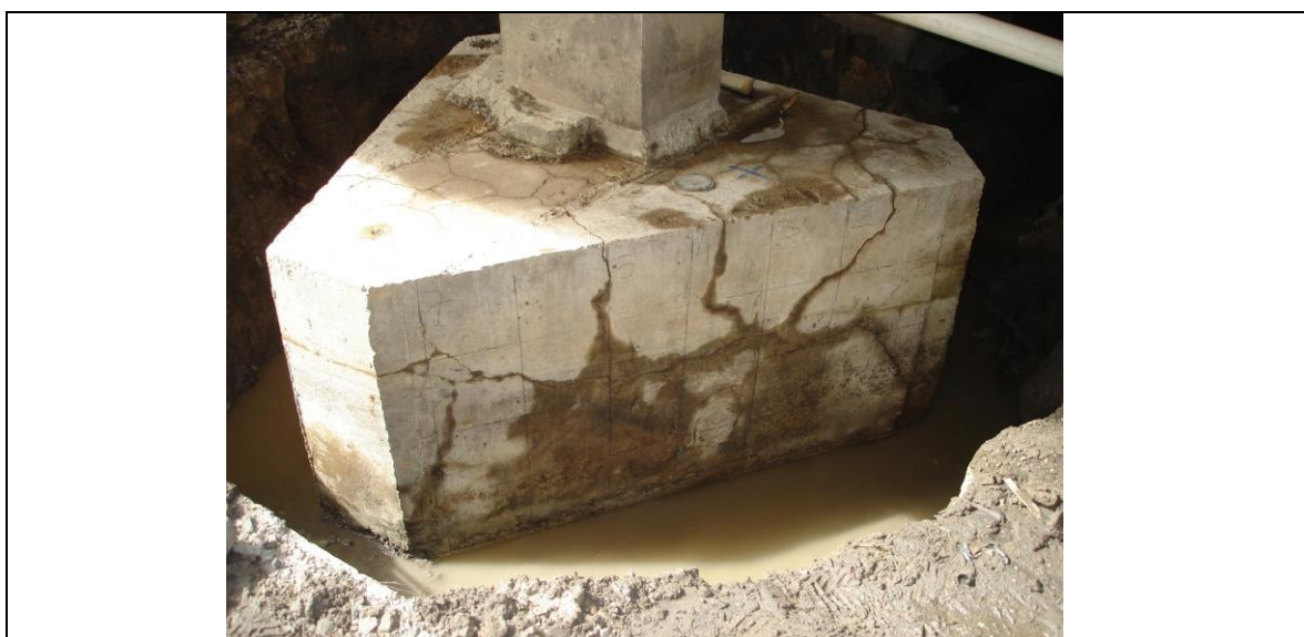
Figura 2.2. Um dos blocos de fundação em que foi empregado o concreto da concreteira B. Fonte: Autor
