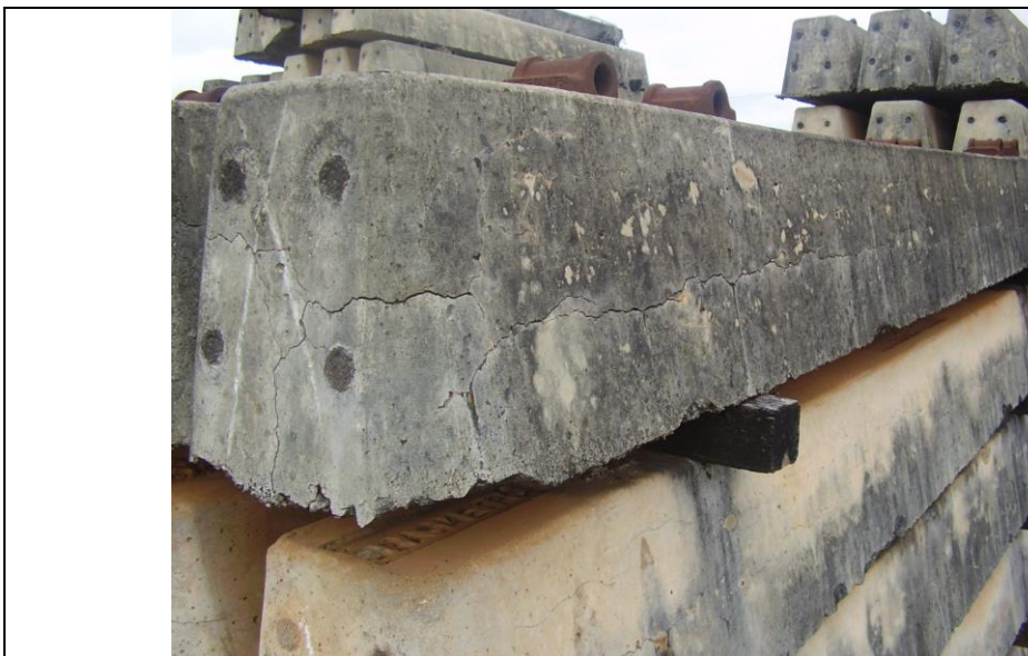
Figura 2.8. Dormentes de concreto protendido no pátio de estocagem fissurados Fonte: Autor
