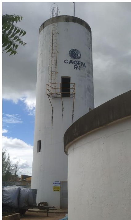
Figura 19: Vista reservatório R1 elevado (R1E)
