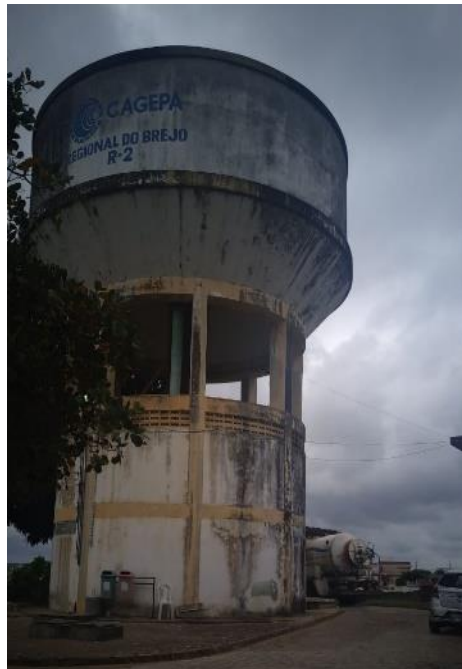
Figura 20: Vista reservatório R2 elevado (R2E).
