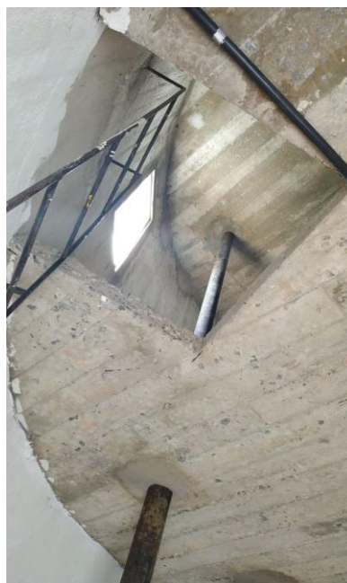
Figura 41: Vista interna R1E.
