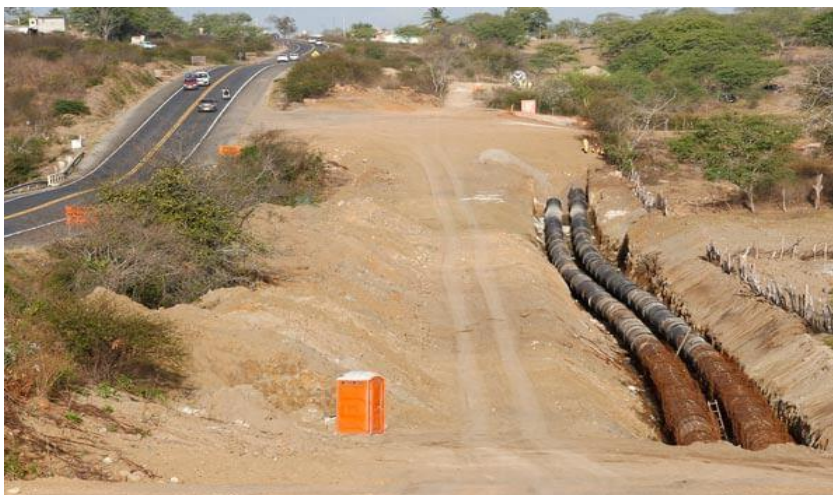
Imagem 14: Serviço de tubulação
