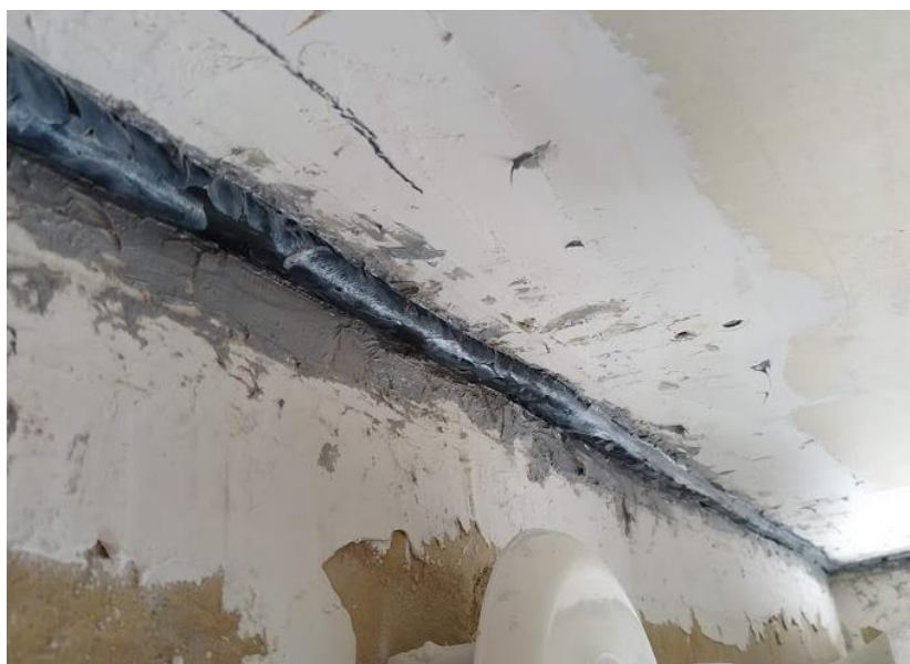
Figura 31-Mangueira instalada com adesivo selante à base de silicone
