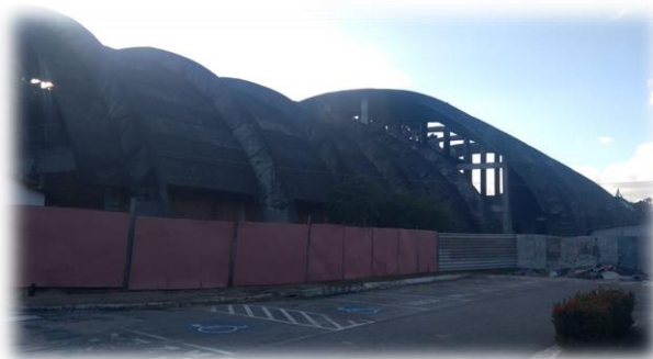
Imagem 18 – Fotografia extraída de obra em andamento ao lado da Reitoria
