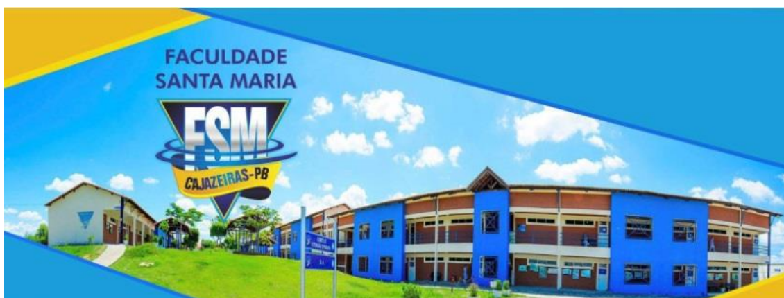
Figura 7 – Vista de alguma das instalações que abriga as atividades acadêmicas da FSM
