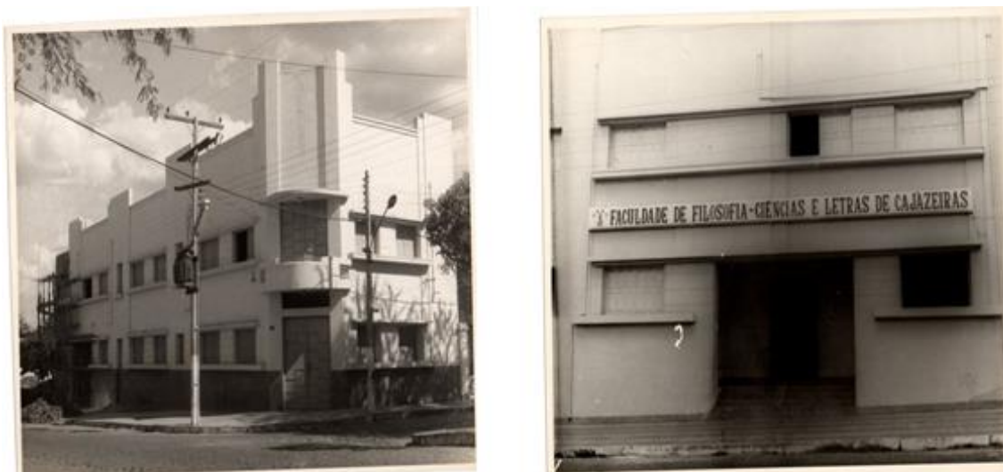
Figura 2 – Primeiro prédio que abrigou as atividades educacionais da FAFIC
