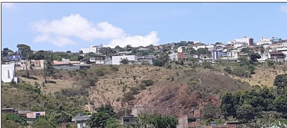
Figura 54. Voçoracamento no bairro Aluízio Pinto no centro urbano do município de Garanhuns.
