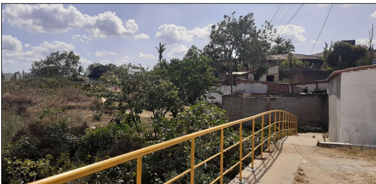
Figura 57. Residências na proximidade da voçoroca no bairro da Liberdade no centro urbano do município de Garanhuns.
