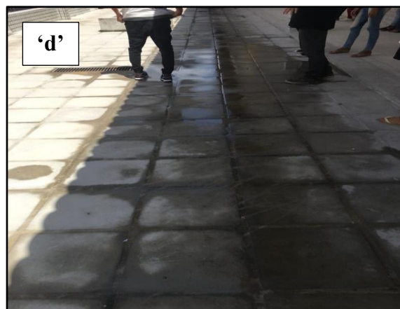
Revestimento do pátio com placas de cimento.
