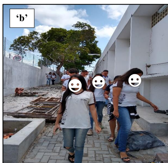
Área interna da escola (calçada lateral das salas em reforma)
