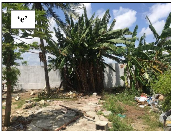
Área interna da escola (“entulhos de reforma”)
