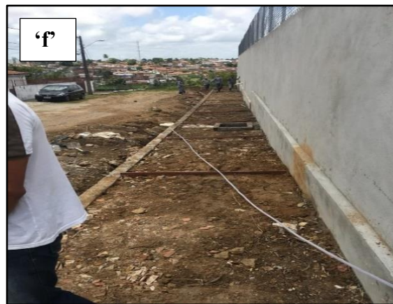
Área externa da escola (calçada em reforma)
