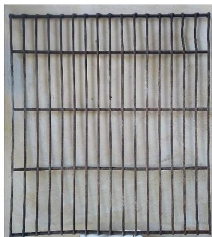
FIGURA 50: Grelha de ferro, separa a câmara de combustão da de cocção, 2020. Fotografia Geraldo M.
