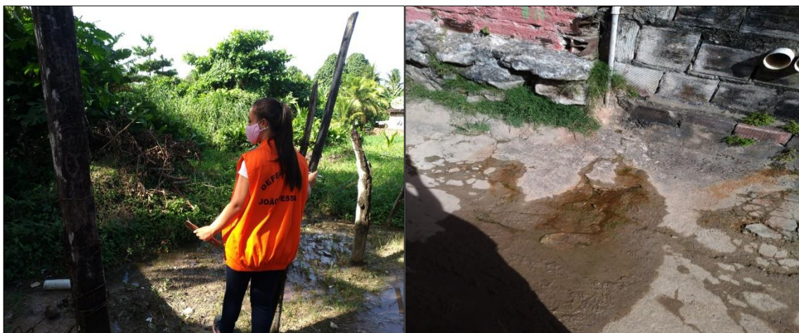
Figura 25 - Problemas de infraestrutura na comunidade Nossa Senhora das Neves: (a) afloramento de água em frente a uma residência e (b) solo encharcado pelo acúmulo de água que aflora em frente às casas
