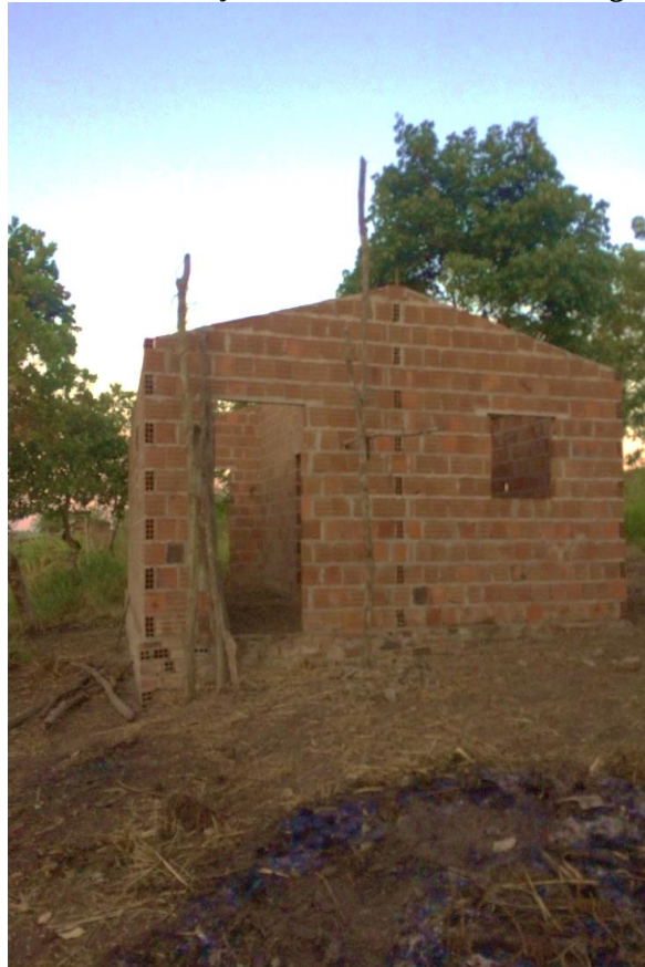
Foto17- Construção da casa da célula familiar agregada no lote
