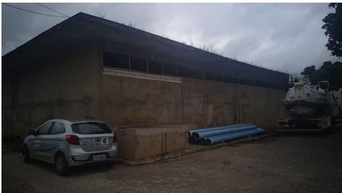
Figura 4.2 – Reservatório R2 apoiado da cidade de Guarabira.
