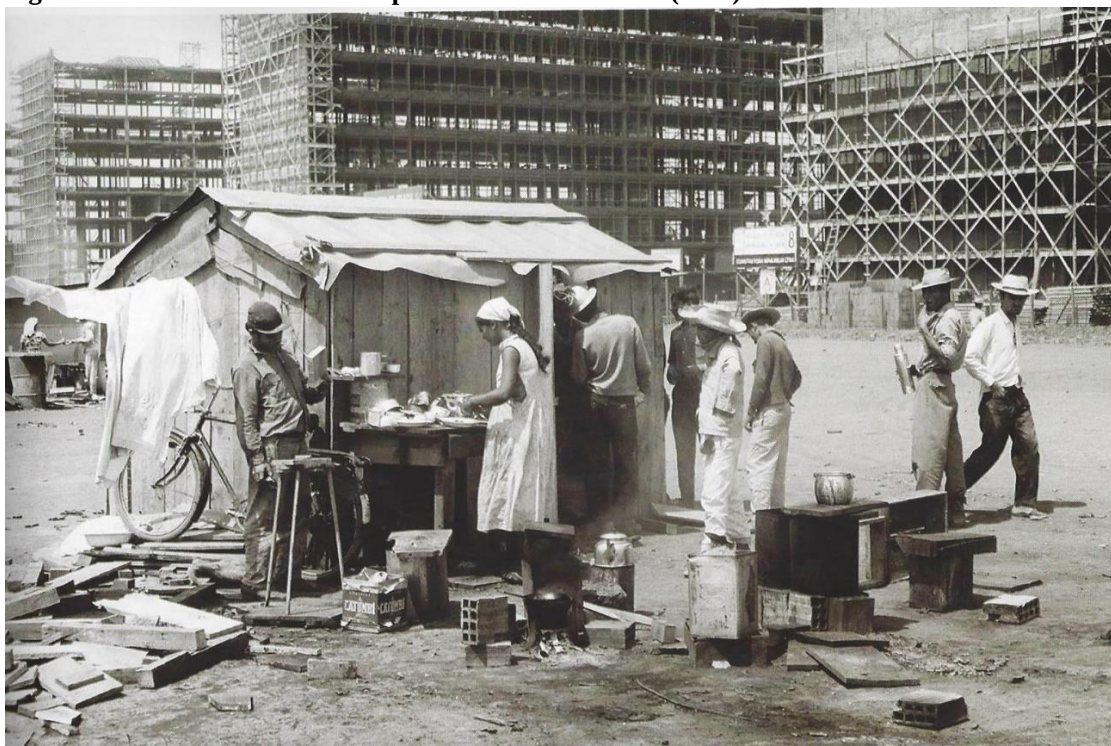
Figura 4- Canteiro de obras da Esplanada dos Ministérios (1959)
