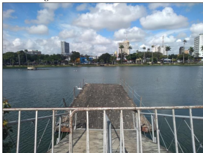
Figura 27: Pier com Deck de Madeira
