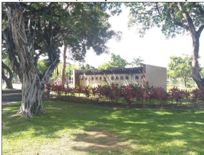
Figura 20: Edificação de Apoio da Guarda Municipal
