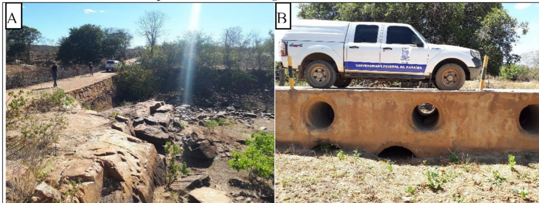
Figura 7: Tipos mais comuns de passagens molhadas. A – Passagem molhada não vazada, de argamassa e blocos de rocha, do tipo vertedouro. B – Passagem molhada vazada, composta por manilhas ao longo de sua estrutura.
