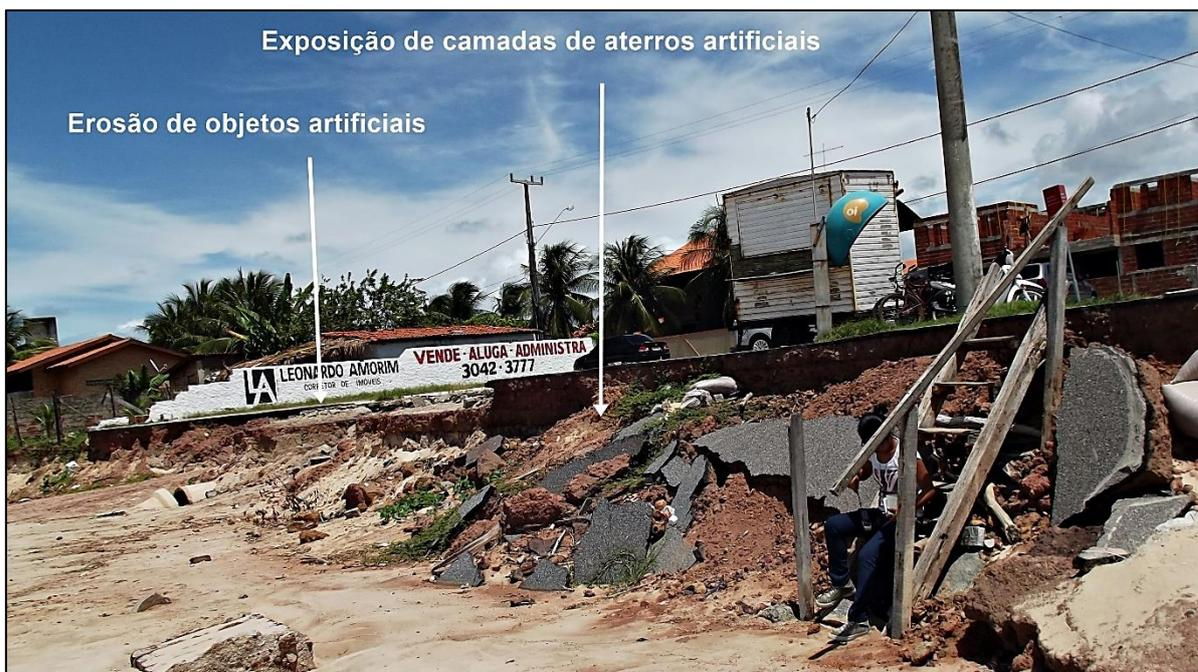
**Figura 38** – Erosão costeira na praia do Seixas com a presença de objetos artificiais destruídos e exposição de camadas de aterros.
