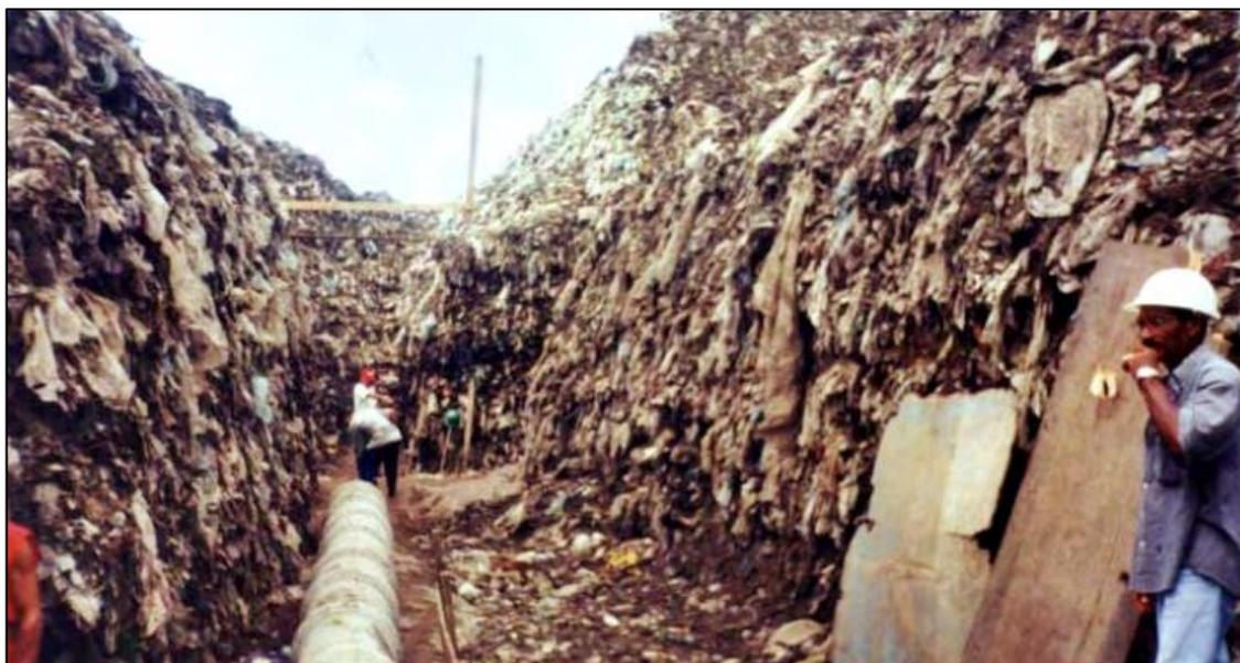
**Figura 25** – Obra para recuperação da área do antigo lixão do Róger, com colocação de dreno para chorume – João Pessoa.
