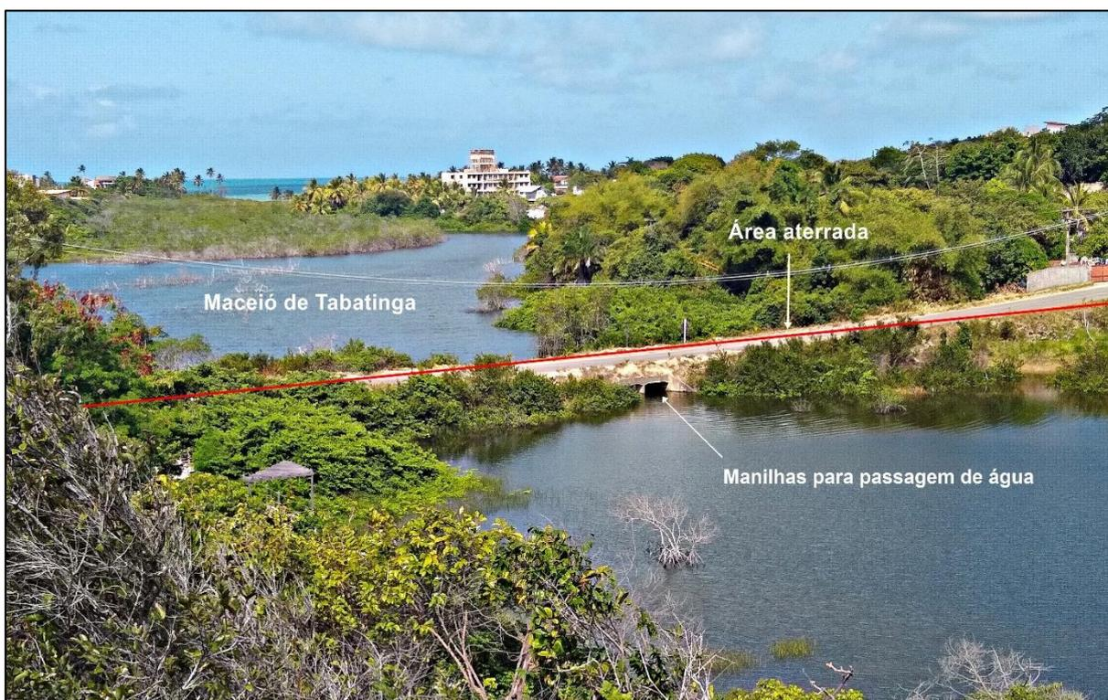
**Figura 62** – Aterro para avenida PB 008, município do Conde Vista do topo do tabuleiro. Foto: Tamires Barbosa (2020).
