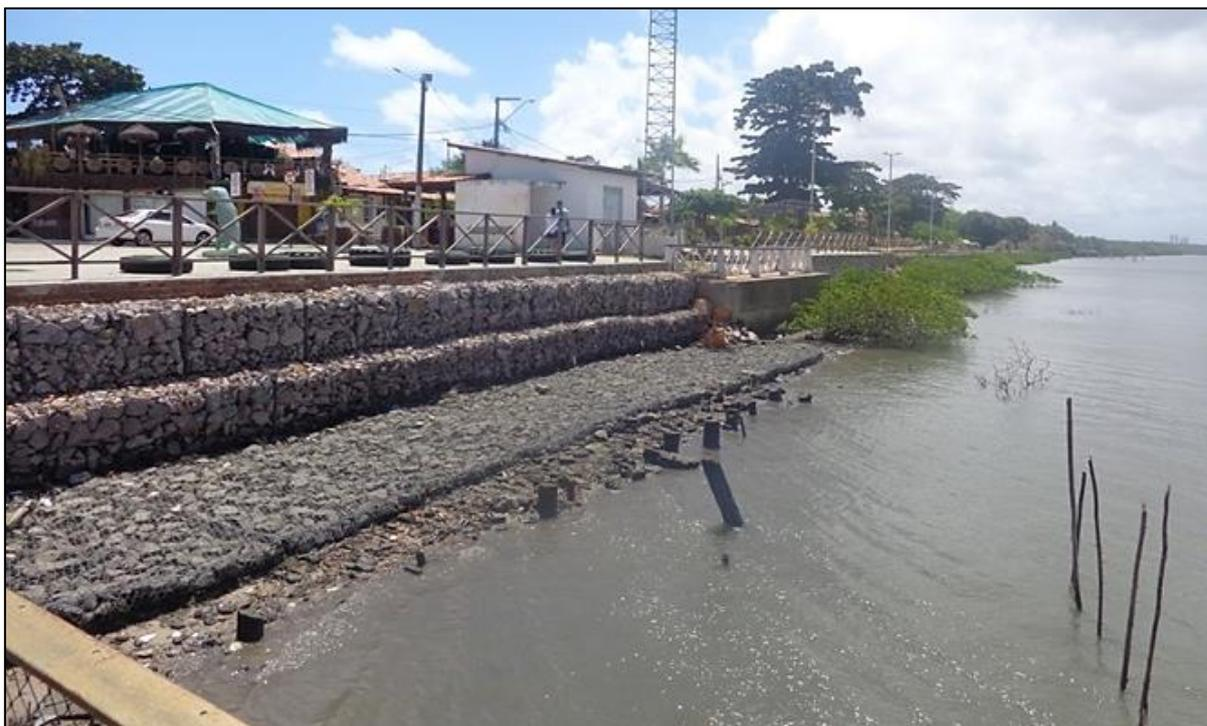
**Figura 52** – Gabiões de granito descaracterizando completamente a planície intertidal no bairro de Jacaré.
