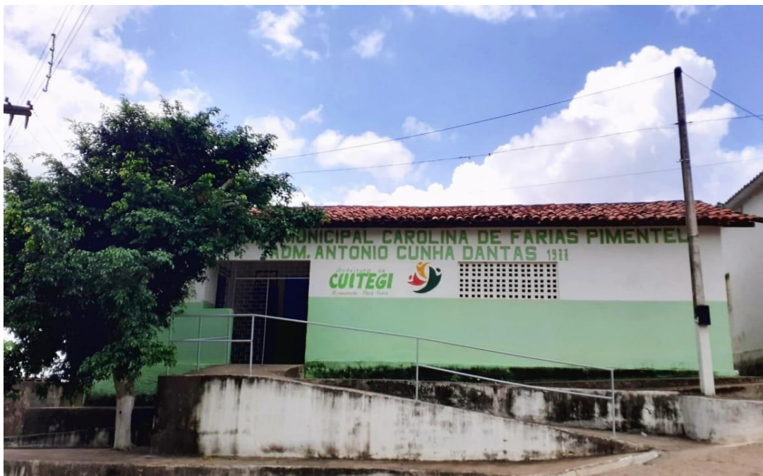
Figura 15 - Escola Municipal Carolina de Farias Pimentel
