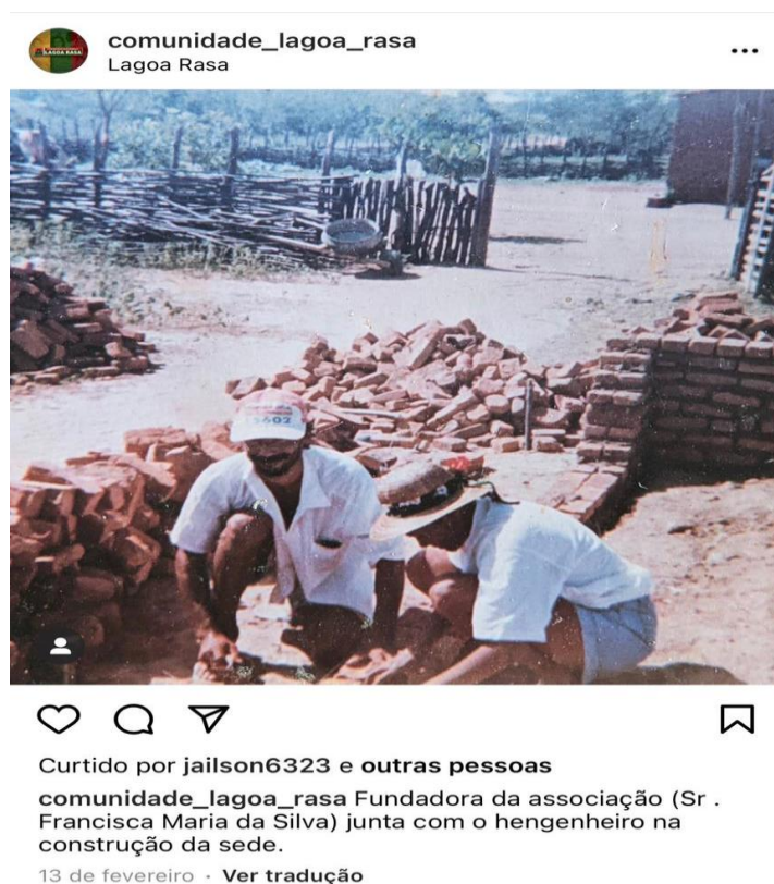
Figura 5: Construção da Associação de moradores da comunidade Lagoa Rasa.
