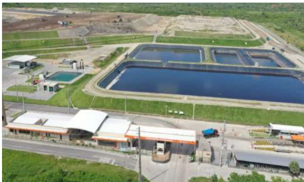
Figura 3: Aterro Sanitário Metropolitano Oeste de Caucaia- ASMOC II.
