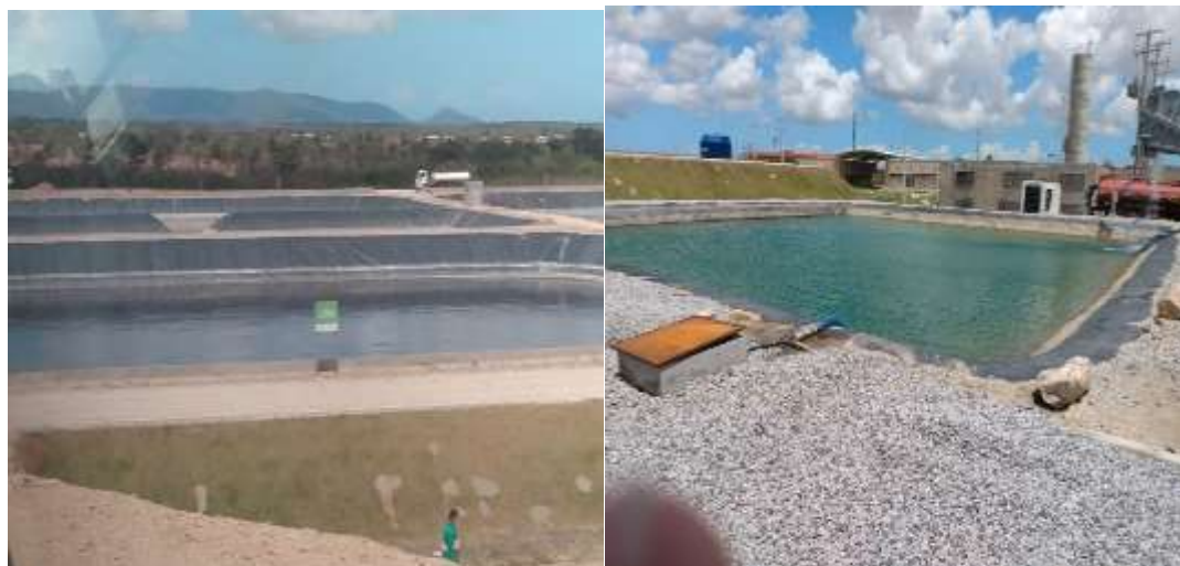
Figura 20 – Lagoa de efluentes sem e com tratamento
