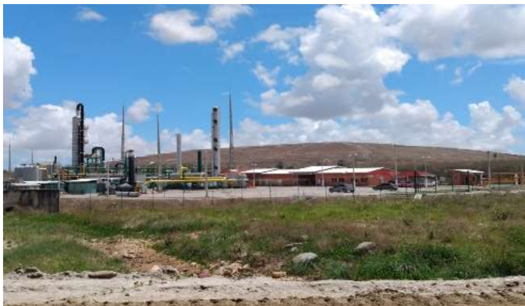
Figura 4: Usina GNR Fortaleza Valorização de Biogás Ltda.
