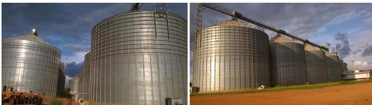
Figura 15. Silos para armazenamento dos grãos de soja e milho da Fazenda. Foto autor.
