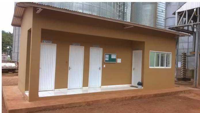
Figura 8. Escritório da Unidade de Beneficiamento de Grãos da Fazenda. Fonte: autor.
