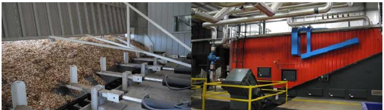
Figura 2. Queimador de biomassa (Fonte: Do autor, 2020).
