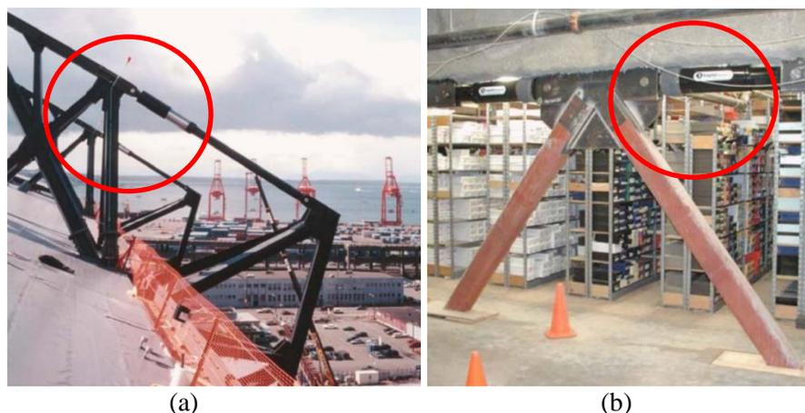
Figura 19 – Amortecedores viscosos reais. (a) Amortecedores viscosos instalados no estádio de baseball em Seattle, EUA; (b) Amortecedor do tipo *chevron damper* instalado em pórtico estrutural. Fonte: Adaptada de Moutinho (2007).
