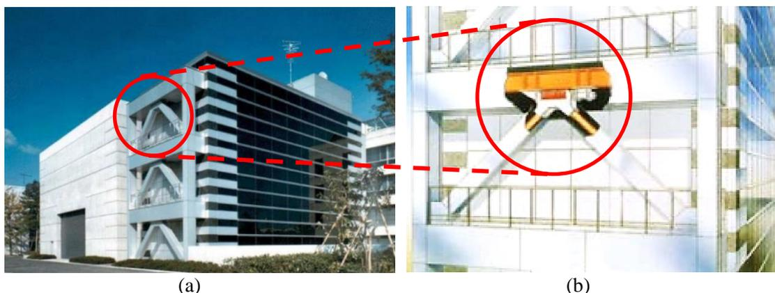
Figura 34 – Amortecedores AVS's. (a) Edifício Instituto Kajima, no Japão; (b) Atuadores hidráulicos comandados eletricamente. Fonte: Kobori *et al.* (1993).
