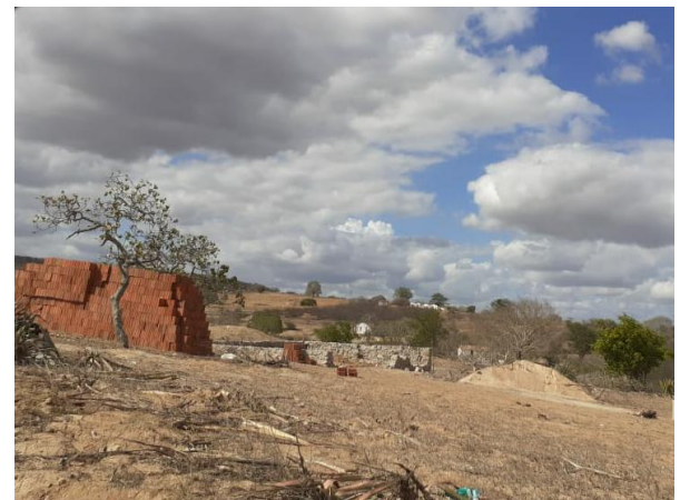
Casa de um beneficiário em construção
