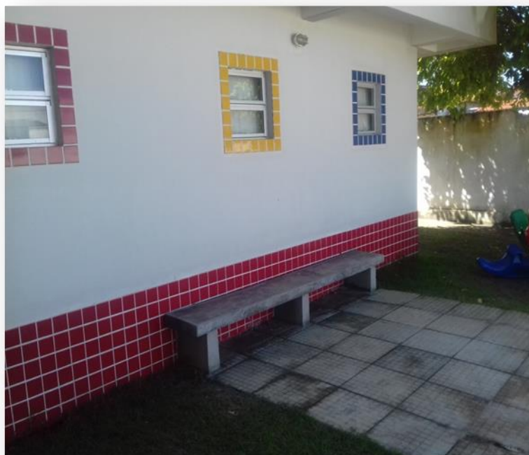
IMAGEM 38 – ÁREA EXTERNA CREI II
