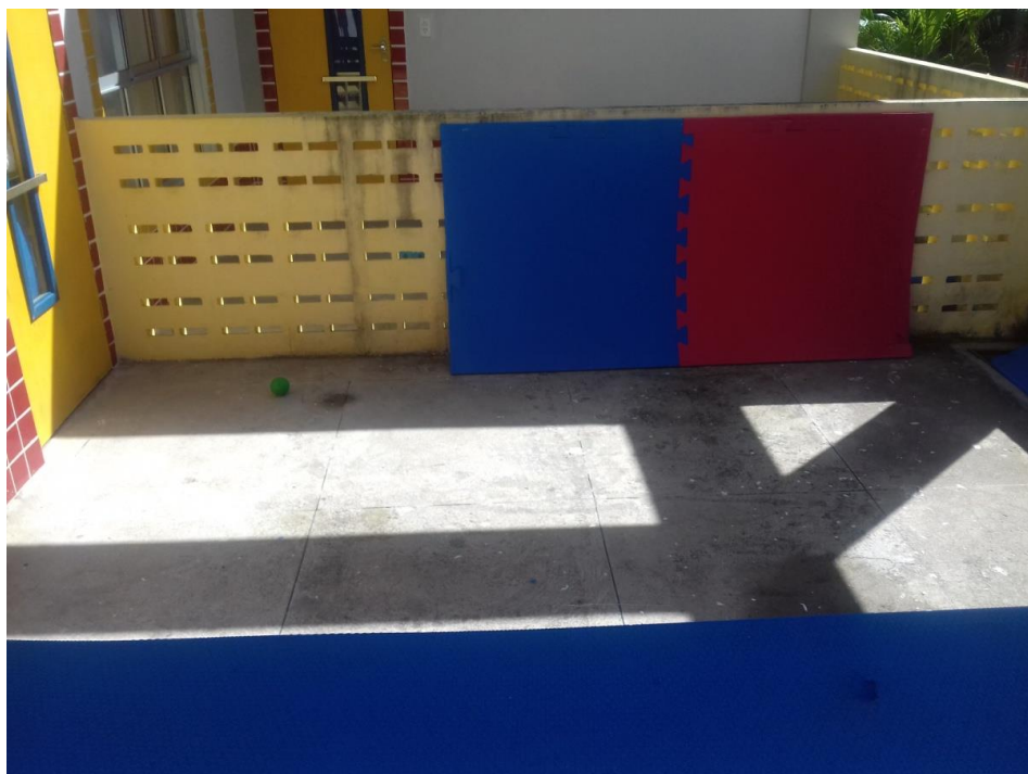
IMAGEM 24 – SOLÁRIO CREI II
