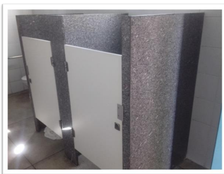
IMAGEM 17 – BANHEIRO CREI II
