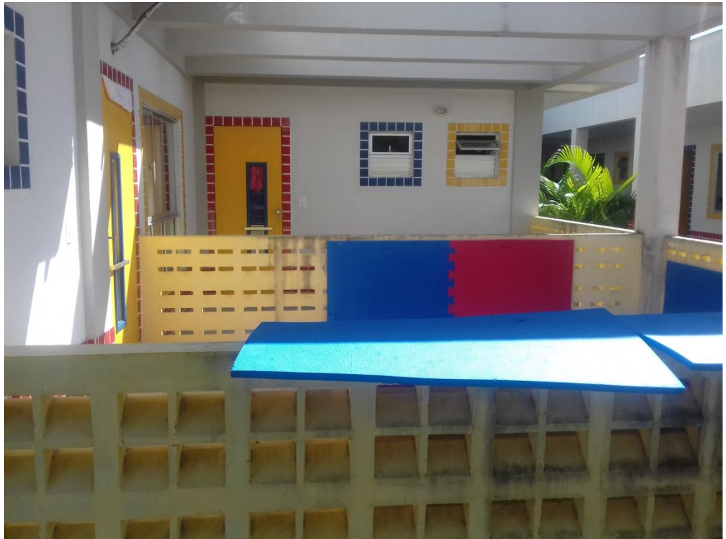
IMAGEM 23 – SOLÁRIO CREI II
