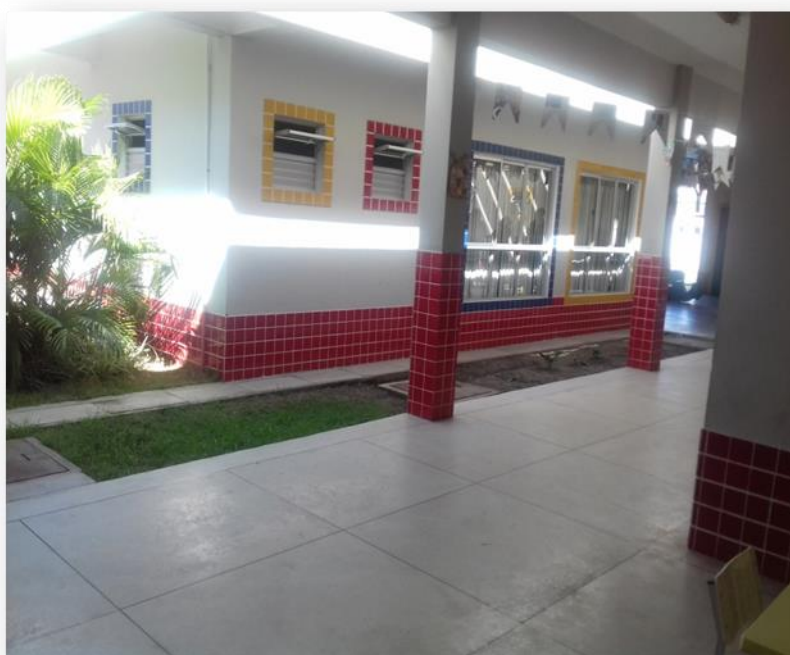
IMAGEM 39 – ÁREA EXTERNA CREI II
