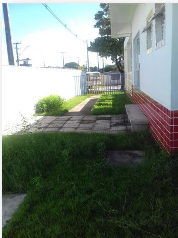
IMAGEM 40 – ÁREA EXTERNA CREI II
