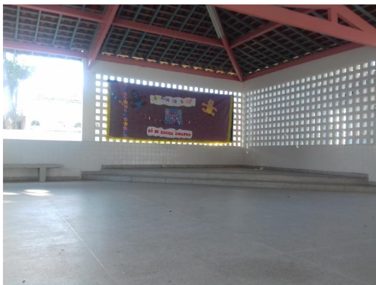
IMAGEM 7 – PÁTIO COBERTO CREI I
