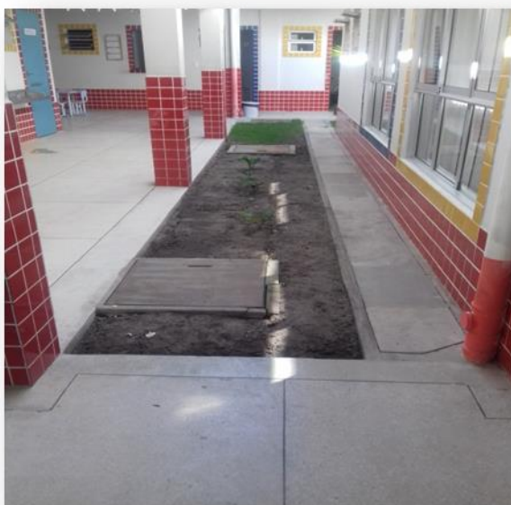
IMAGEM 41- ÁREA EXTERNA CREI II
