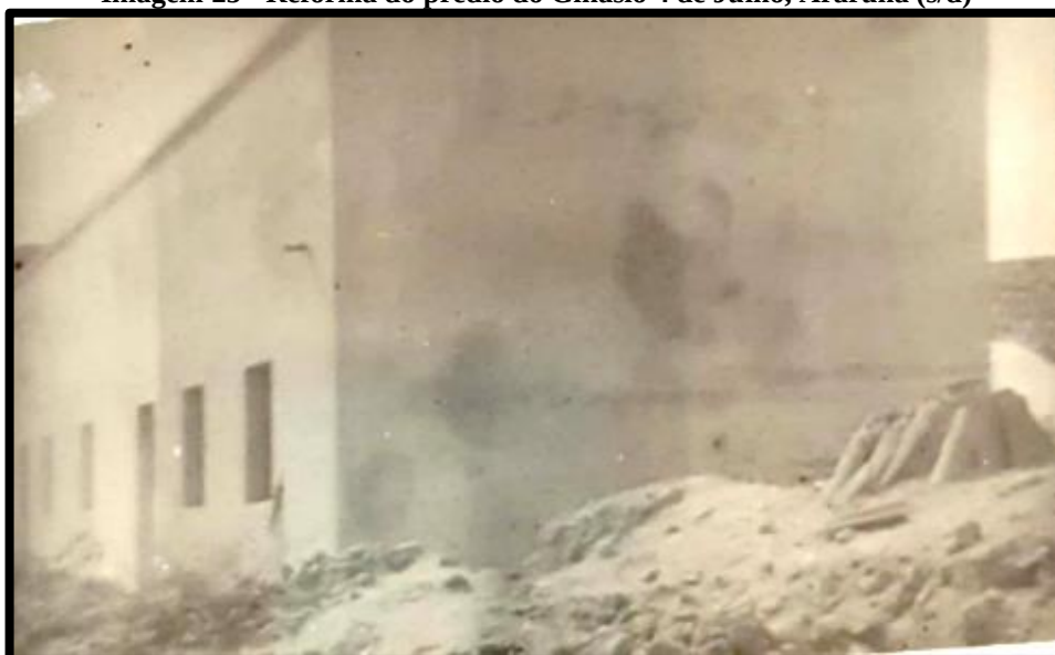
Imagem 25 - Reforma do prédio do Ginásio 4 de Julho, Araruna (s/d)
