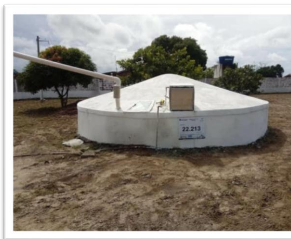
Fotografia 2 – Cisterna captação da água da chuva: da Escola Júlio Feliciano
