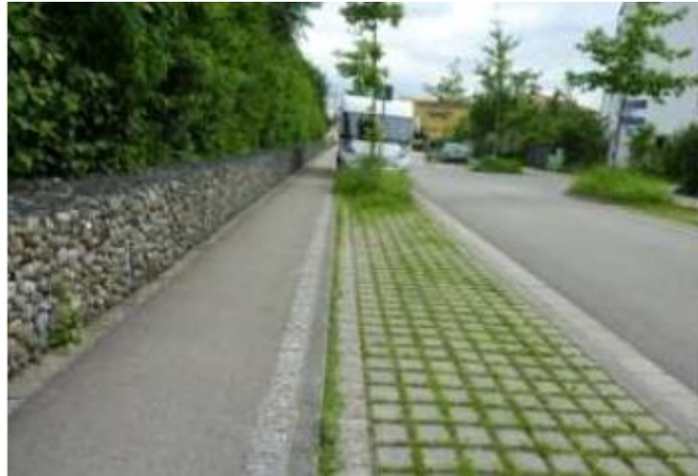
Figura 5. Pavimento permeável em Freiburg, Alemanha
