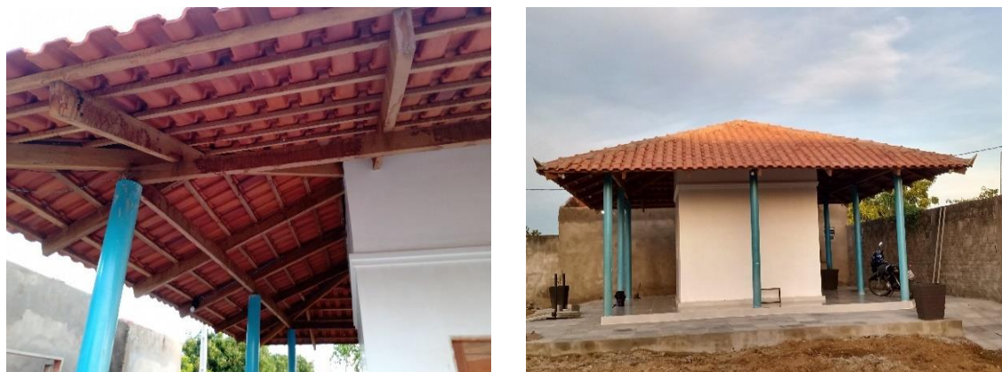
Figura A.34 - Telhado após conclusão
