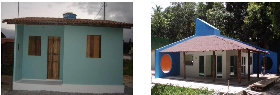
Figura 2.18 - Casas de gesso na região do polo gesseiro do Araripe, PE
