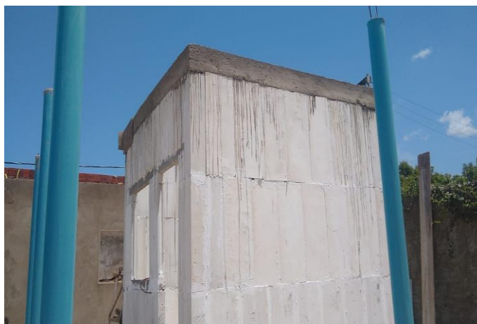
Figura A.31 - Cinta concretada
