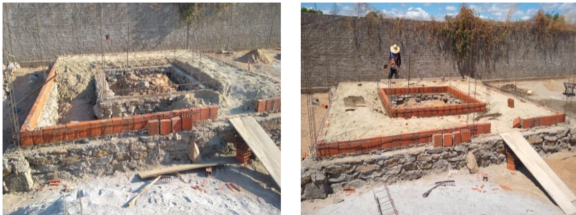
Figura A.18 - Alvenaria de embasamento
