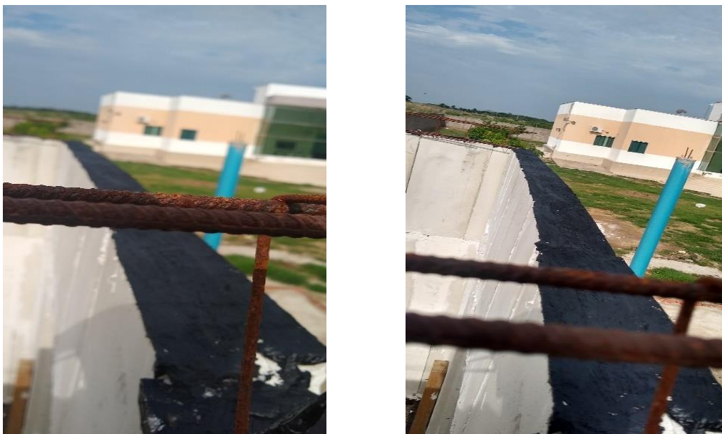
Figura A.30 - Pintura isolante para recebimento da cinta
