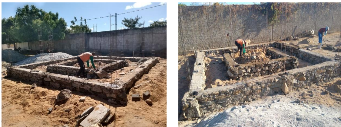
Figura A.17 - Fundação em alvenaria argamassada
