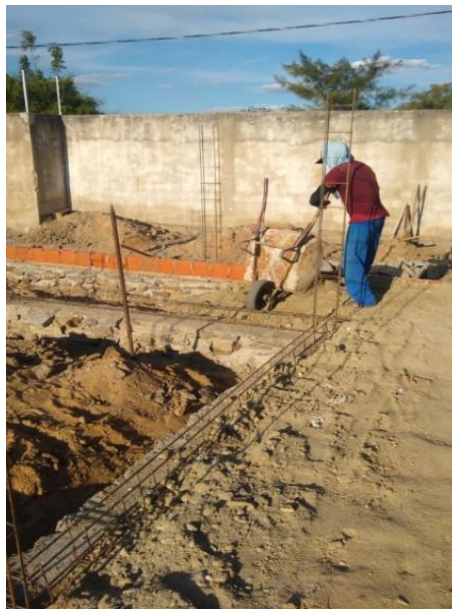
Figura A.20 - Aterro das fundações
