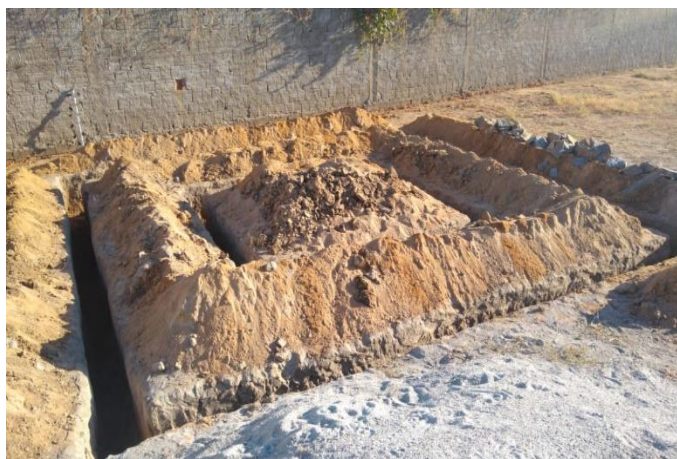
Figura A.16 - Escavação das fundações
