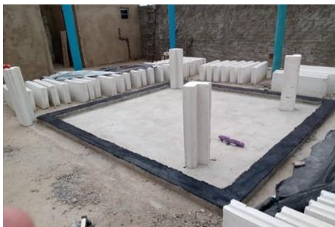
Figura A.23 - Cinta de concreto impermeabilizada
