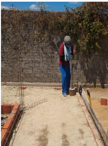
Figura A.21 - Compactação do aterro
