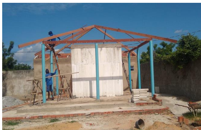
Figura A.33 - Madeiramento do telhado
