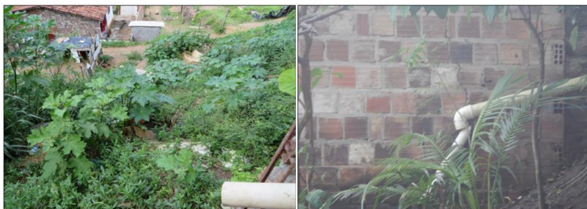
Figura 27 – Lançamento de águas servidas nos setores de alto risco SR 14, localizado no bairro de Cruz das Armas, e SR 16, localizado no bairro do Cristo Redentor.
