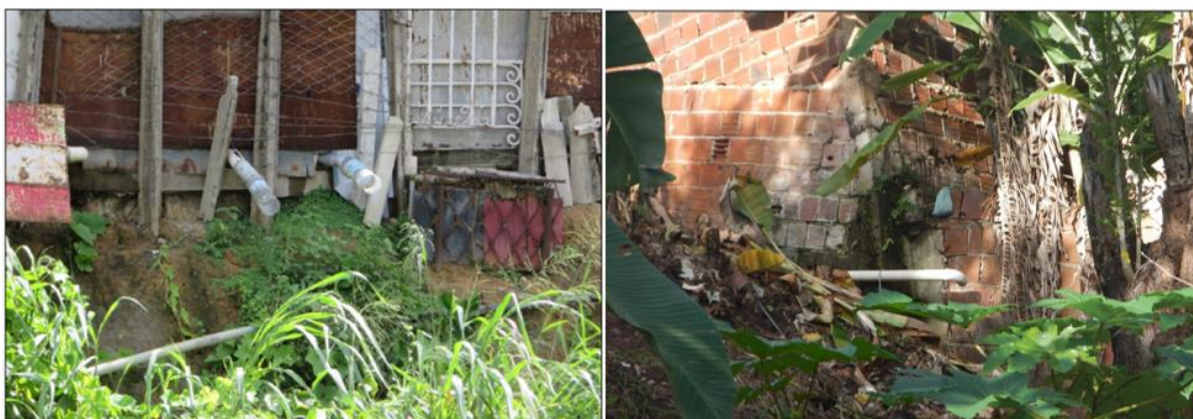
Figura 26 – Lançamento de águas servidas nos setores de alto risco SR 11, localizado no bairro de Oitizeiro, e SR 05, localizado no bairro Ilha do Bispo.
