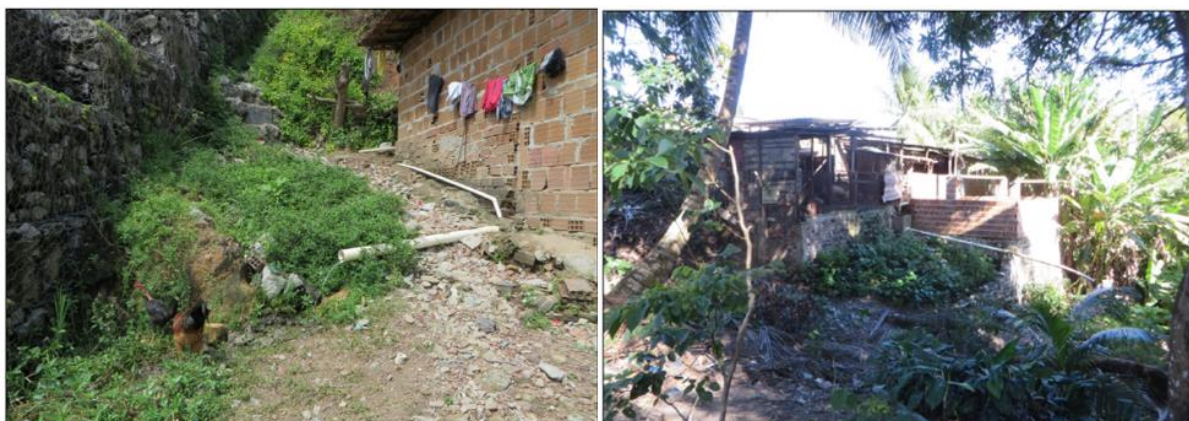
Figura 31 – Lançamento de águas servidas nos setores de muito alto risco SR 23, localizado no bairro do Varjão, e SR 29, localizado no bairro de Valentina.
