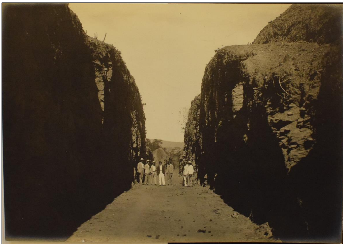
Figura 15 – Corte em rocha no trecho Lavras-Aurora
