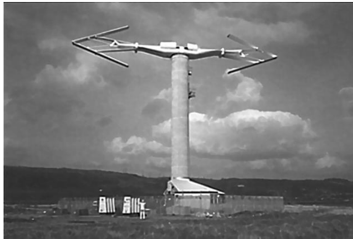
Figura 13 - Aerogerador Musgrove. (Fonte: Tjiu et al. , 2015)
