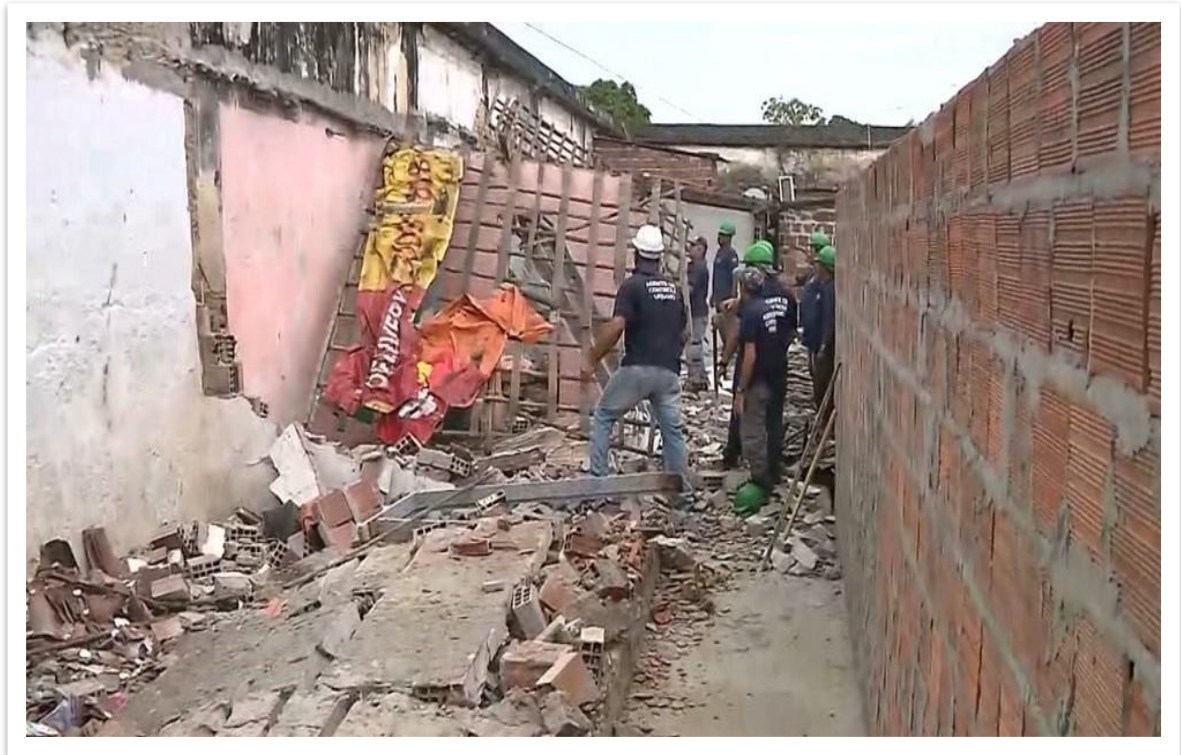
Figura 15-Agentes da PMJP no momento da demolição de casa na Vila Nassau
