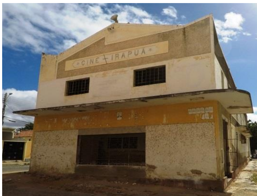
Figura 19 - Cine Irapuã foi visitado em julho de 2018, em Belém de São Francisco. A difusora ainda está instalada em seu topo, ao centro.
