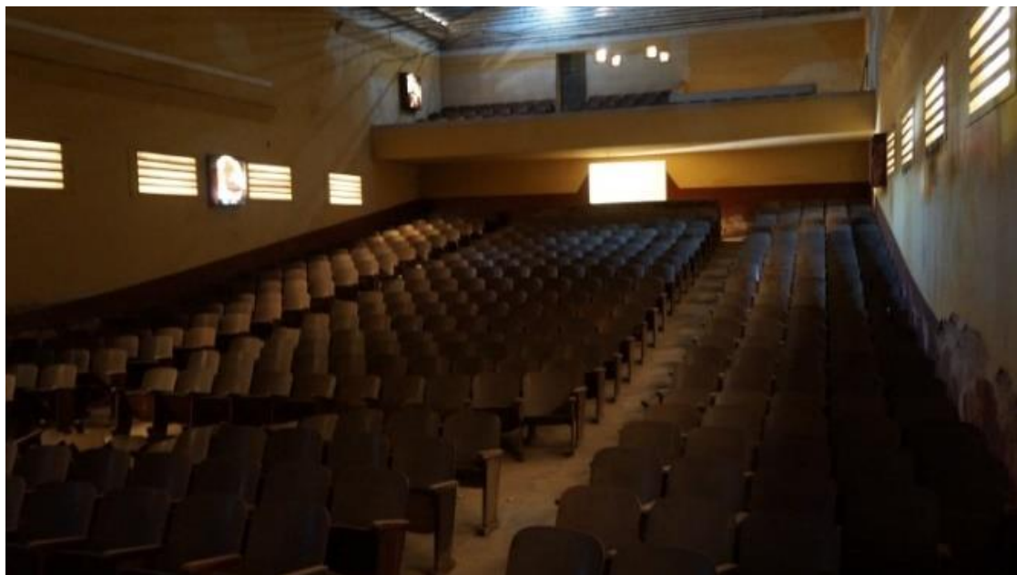
Figura 20 - Cine Irapuã. No salão principal é possível observar o declive parabólico e o sistema de ventilação lateral.
