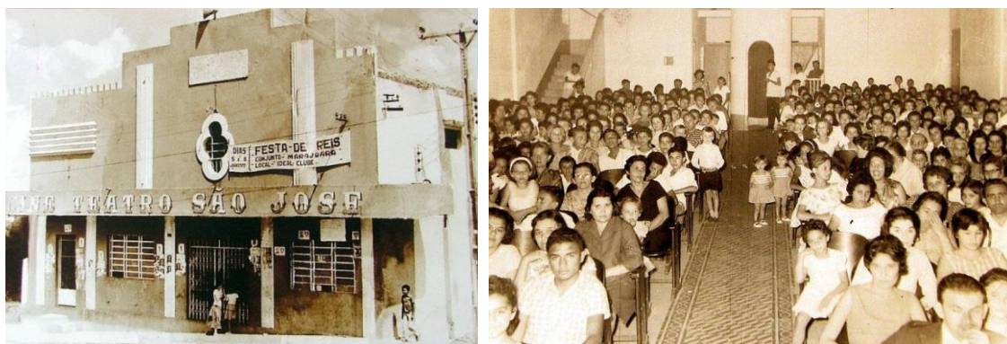
Figura 26, Figura 27 - Cine Teatro São José (São José do Egito). Em sua fachada, salão principal e difusora no topo, o Cine Teatro São José se assemelha com outros cinemas do sertão pernambucano, como o Cine Santa Terezinha (Ouricuri) e o Cine Salgueiro (Salgueiro).
