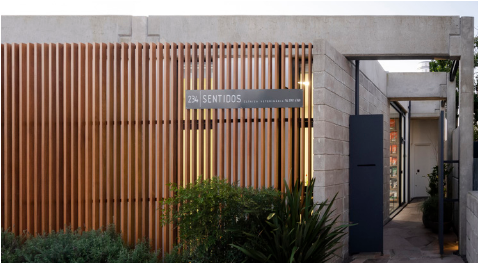
FIGURA 10. Fachada da clínica. Fonte: ArchDaily.
