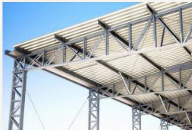
Imagem ilustrativa mostrando um sistema de vigas e pilares em treliças planas. Fonte: .engenhariafmx.com
