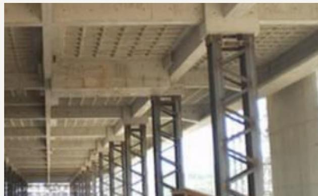
Imagem ilustrativa mostrando um sistema de laje nervurada apoiada sobre vigas de concreto armado. Fonte: MARTINS, João, 2018.
